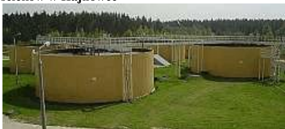
Rysunek 2. Reaktory biologiczne oczyszczalni ścieków w Hajnowce
