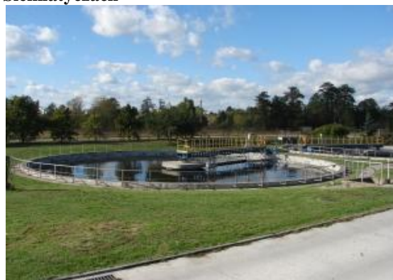
Rysunek 3. Oczyszczalnia ścieków w Siemiatyczach
